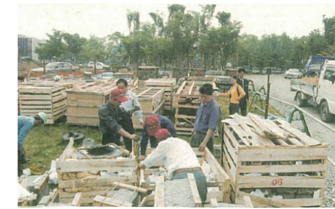
建設の様子【久留米市より提供】
